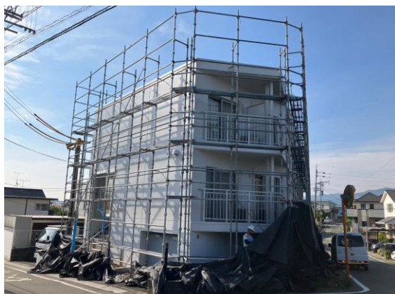
新しく入居する方のために先日外壁の塗り替え工事を行いました
